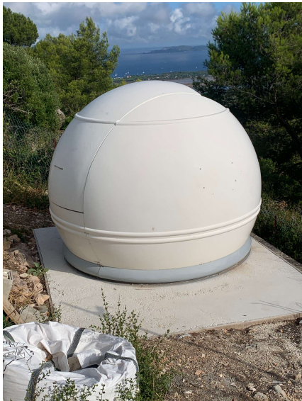
Coupole motorisée pilotable Hébergée par l'OPF à Hyères
